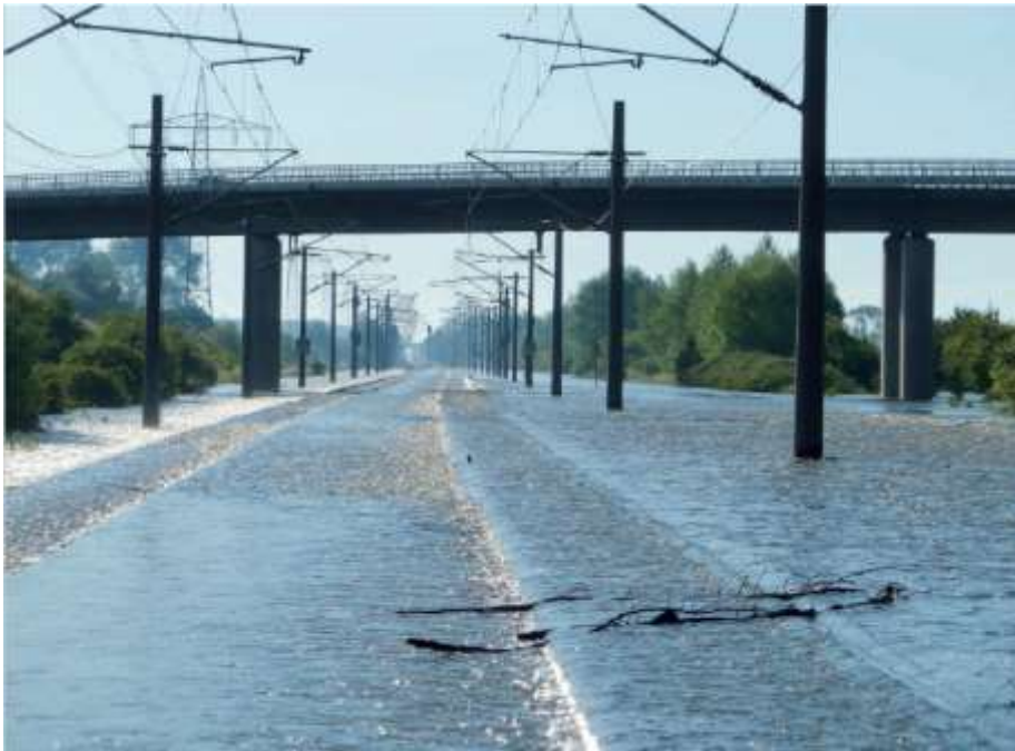
Abbildung 5 Fotoaufnahme der überfluteten Strecken vom 11. Juni 2013 (©Hebenstreit, Schwurack et al. 2014, S. 22)
